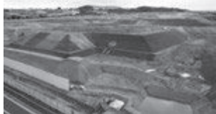
造成が進む駅西側
