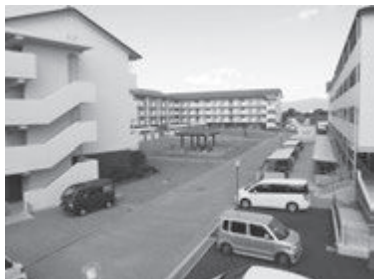
大和郡山市の県営小泉住宅
