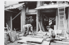
古い石、井戸、古木。工事現場
